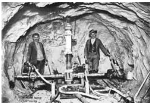
Maschinenvortrieb im Sohlstollen mit 3-Bohrmaschinen im harten Gebirge.
