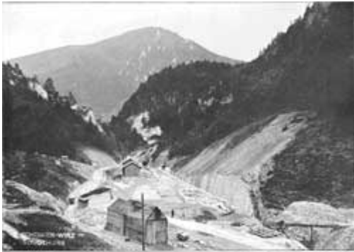
Station Gännsbrunnen mit Tunnelportal und Wasserstollen
